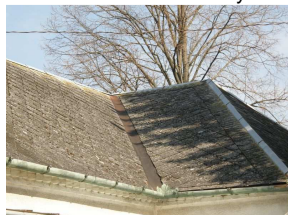
Obr.13 Stavebné defekty budovy – azbestová krytina, statická porucha, prehnité časti strešnej konštrukcie, omietky
