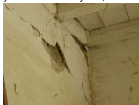
Obr.13 Stavebné defekty budovy – azbestová krytina, statická porucha, prehnité časti strešnej konštrukcie, omietky
