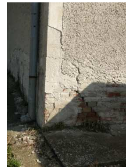
Obr.12 Porucha založenia
