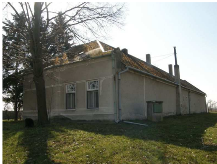
Obr.13 Stavebné defekty budovy – azbestová krytina, statická porucha, prehnité časti strešnej konštrukcie, omietky
