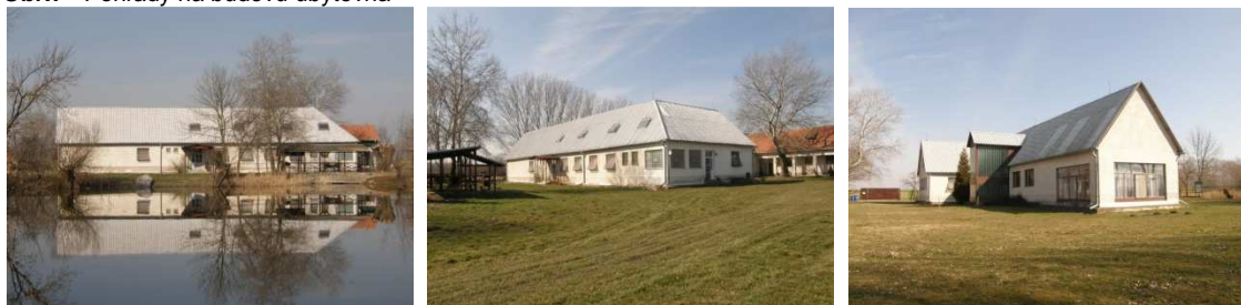
Obr.7 Pohľady na budovu ubytovňa
