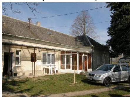
Obr.11 Pohľady na budovu stavby
