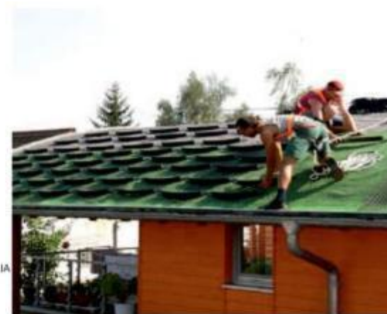
Zachytávače substrátu je možné ukotvovať aj priamo do textílie. Tento spôsob sa používa pri sedlových, alebo oblúčkových strechách.
