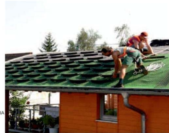
Zachytávače substrátu je možné ukotvovať aj priamo do textílie. Tento spôsob sa používa pri sedlových, alebo oblúčkových strechách.
