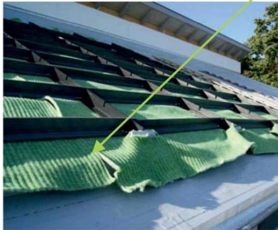
Konštrukcia pre zachytávanie substrátu pri vyšších sklonoch (do 45 stupňov). Je potrebná predpríprava kotvenia stabilizačných krížov pri konštruovaní strechy. Pre akumuláciu vody sa využívajú hydroakumulačné textílie.
