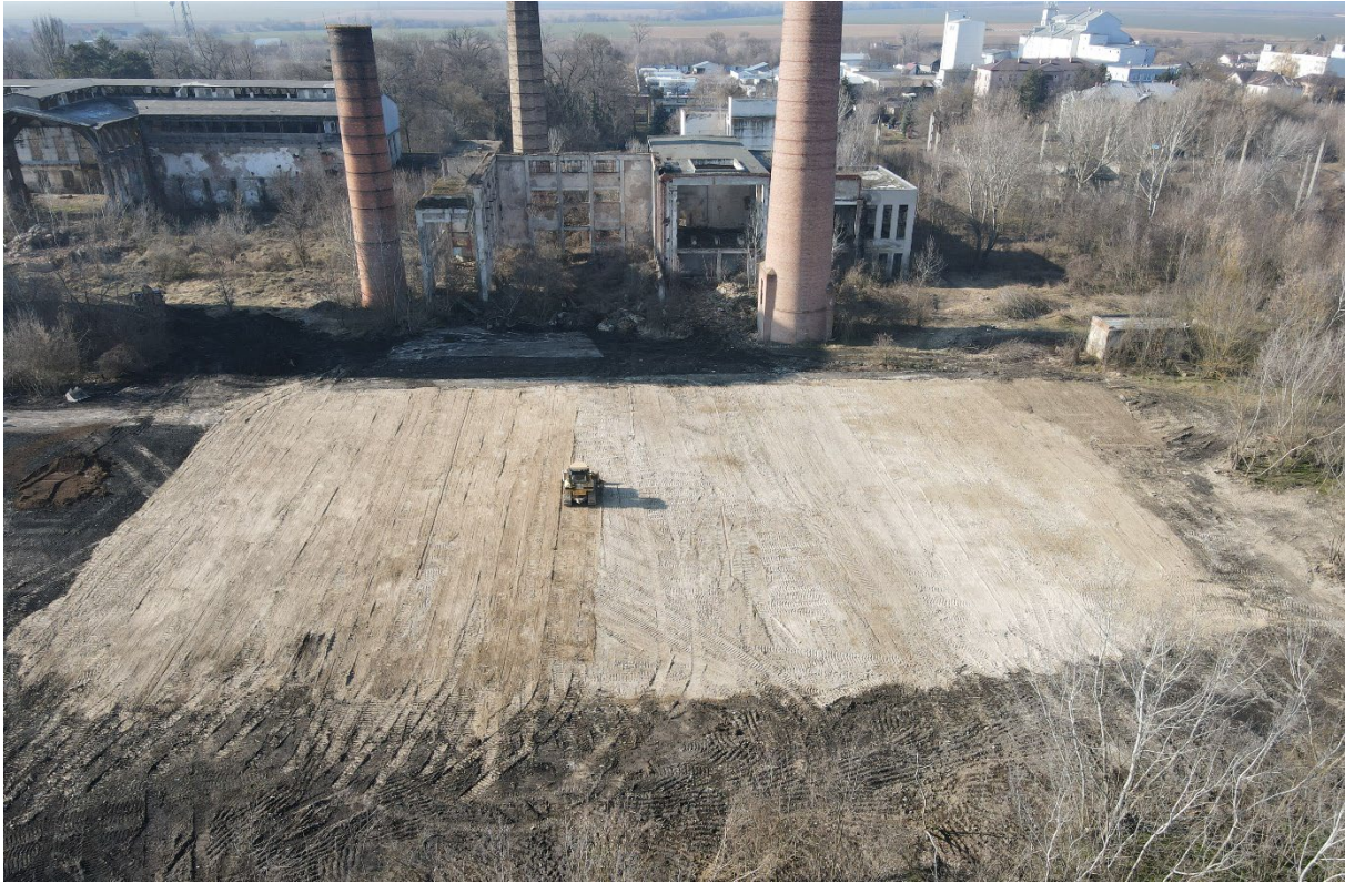
Obr. 3 Pohľad na zre kultivovanú plochu po sanácii v areáli bývalého cukrováru v Pohronskom Ruskove (5)
