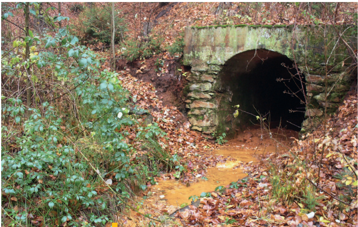
11 Banská lokalita Poproč-Petrova dolina – opustené ložisko antimónových rúd. Ťažba Sb rudy sa začala v 17. storočí a definitívne bola ukončená v roku 1965. Štôlna Agnes s výtokom banských vôd s precipitáciou Fe okrov obsahmi As a Sb. V portáli štôlne sa od roku 2013 realizoval pilotný projekt pasívnej geochemickej bariéry na čistenie banských vôd.
