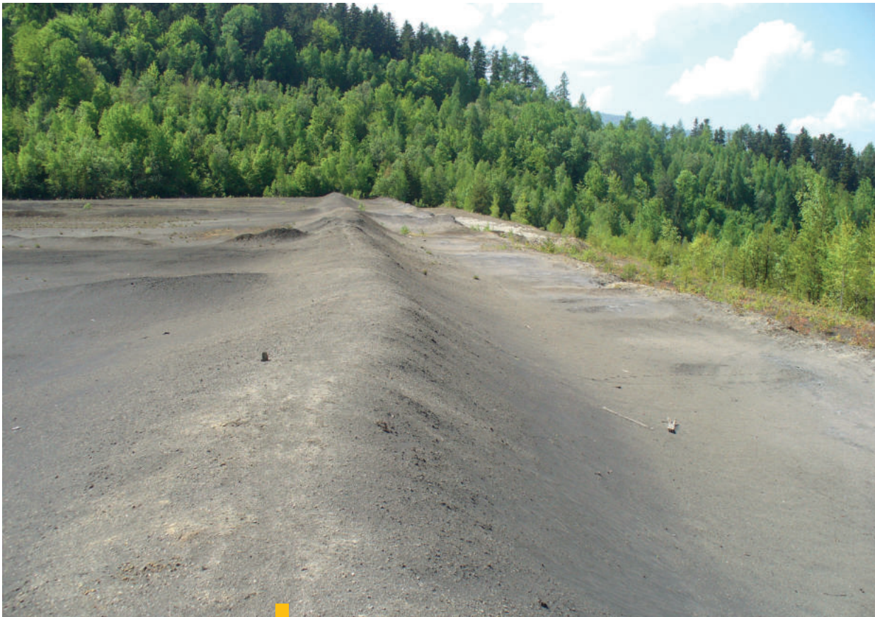
4 Pohľad na odkalisko Slovinky s odpadom po ťažbe a spracovaní sideritovo-sulfidickej rudy.
