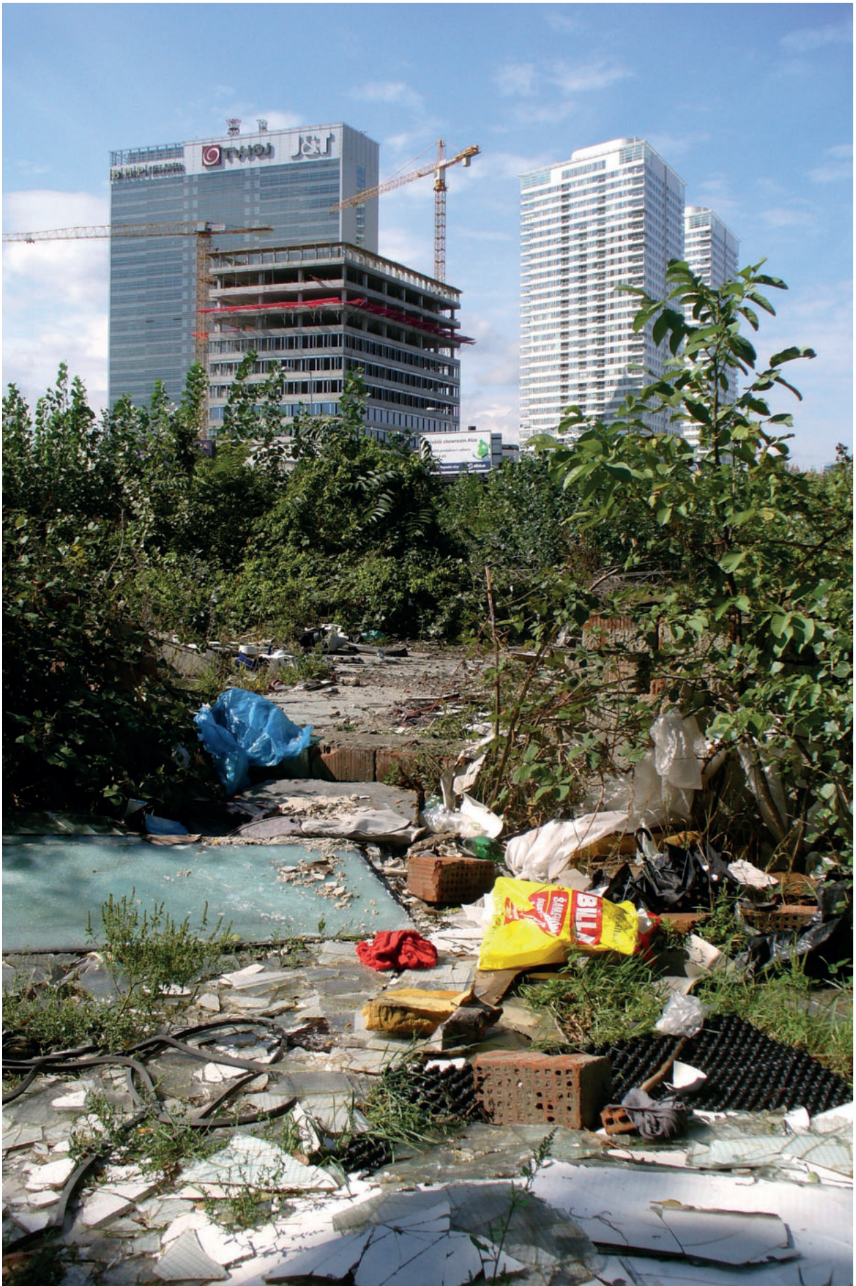
Bratislava-Staré Mesto – Apollo – širší priestor bývalej rafinérie – sanácia EZ pri výstavbe komplexu EUROVEA II | foto: Ing. Jaromír Helma, PhD., SAŽP
