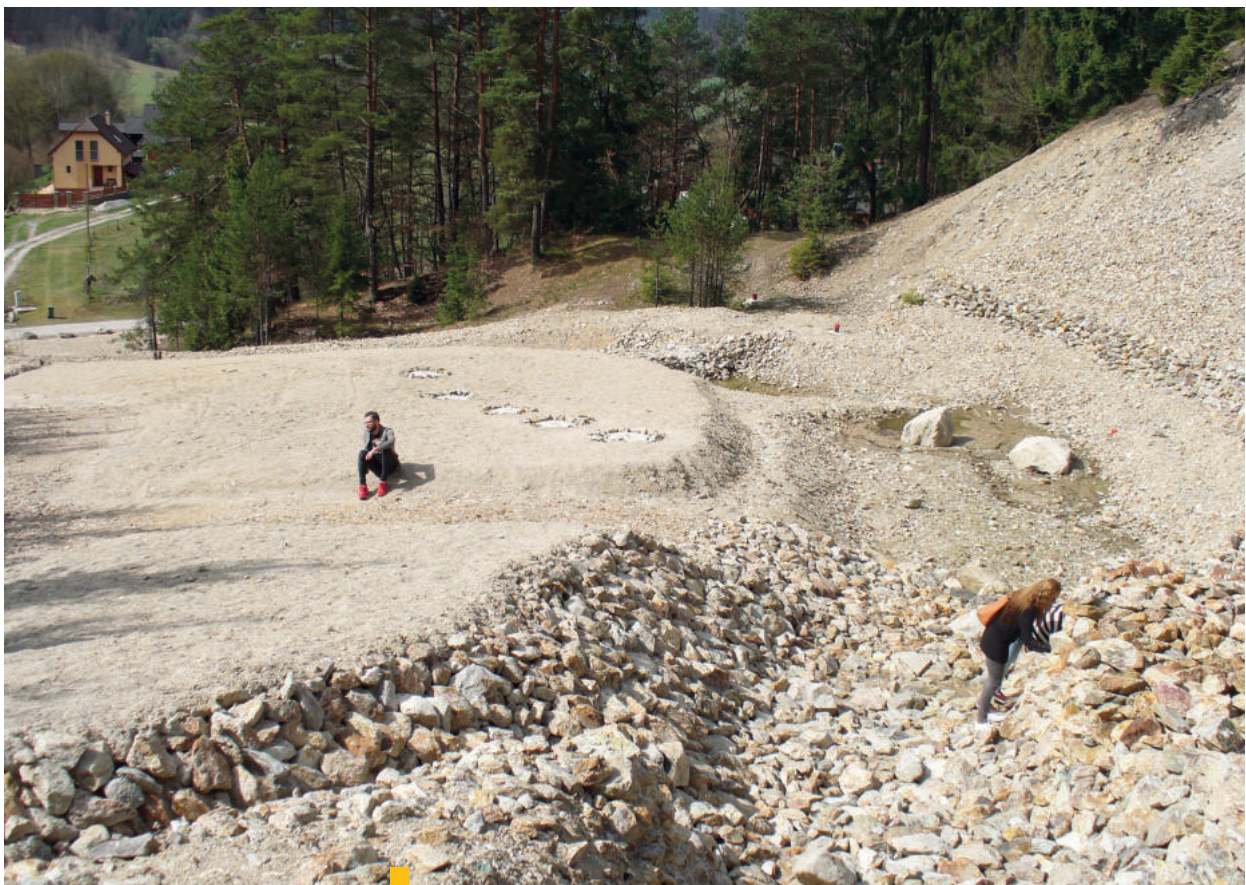
7 Obr. 6 a 7 – banská lokalita Ľubietová-Podlipa – stav po sanácii environmentálnej záťaže po banskej činnosti – ťažbe a spracovaní medených a železných rúd
