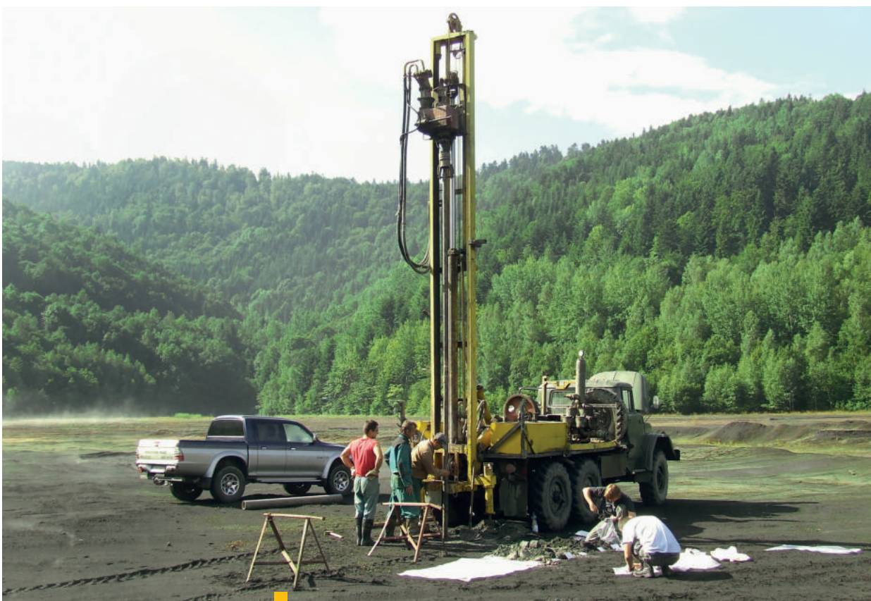
5 Prieskumné vrtné práce na odkalisku Slovinky. Vo vrchnej časti odkaliska je súvislá vrstva jemnozrnnej priemyselnej strusky o hrúbke cca 5 až 6 m z Kovohút Krompachy. Povrchová vrstva nie je zrekultivovaná, ide o tzv. suché odkalisko.
