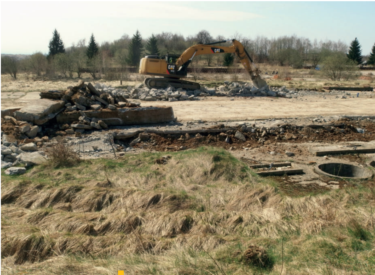
24 Recirkulačná jednotka pred výkopom [15]
