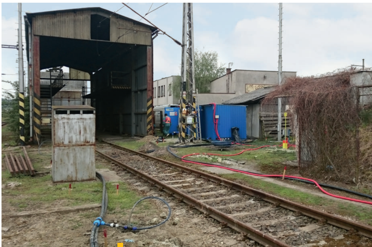
8 Sanačná stanica s dvoma sanačnými bunkami (modré kontajnery v pozadí) zdroj: MŽP SR
