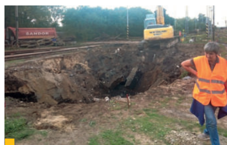
5 Z kontrolného diera | zdroj: MŽP SR
