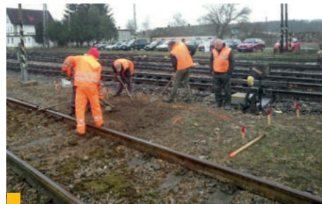
4 Pracná realizácia ručných predkopov v priestore aktívneho koľajiska
