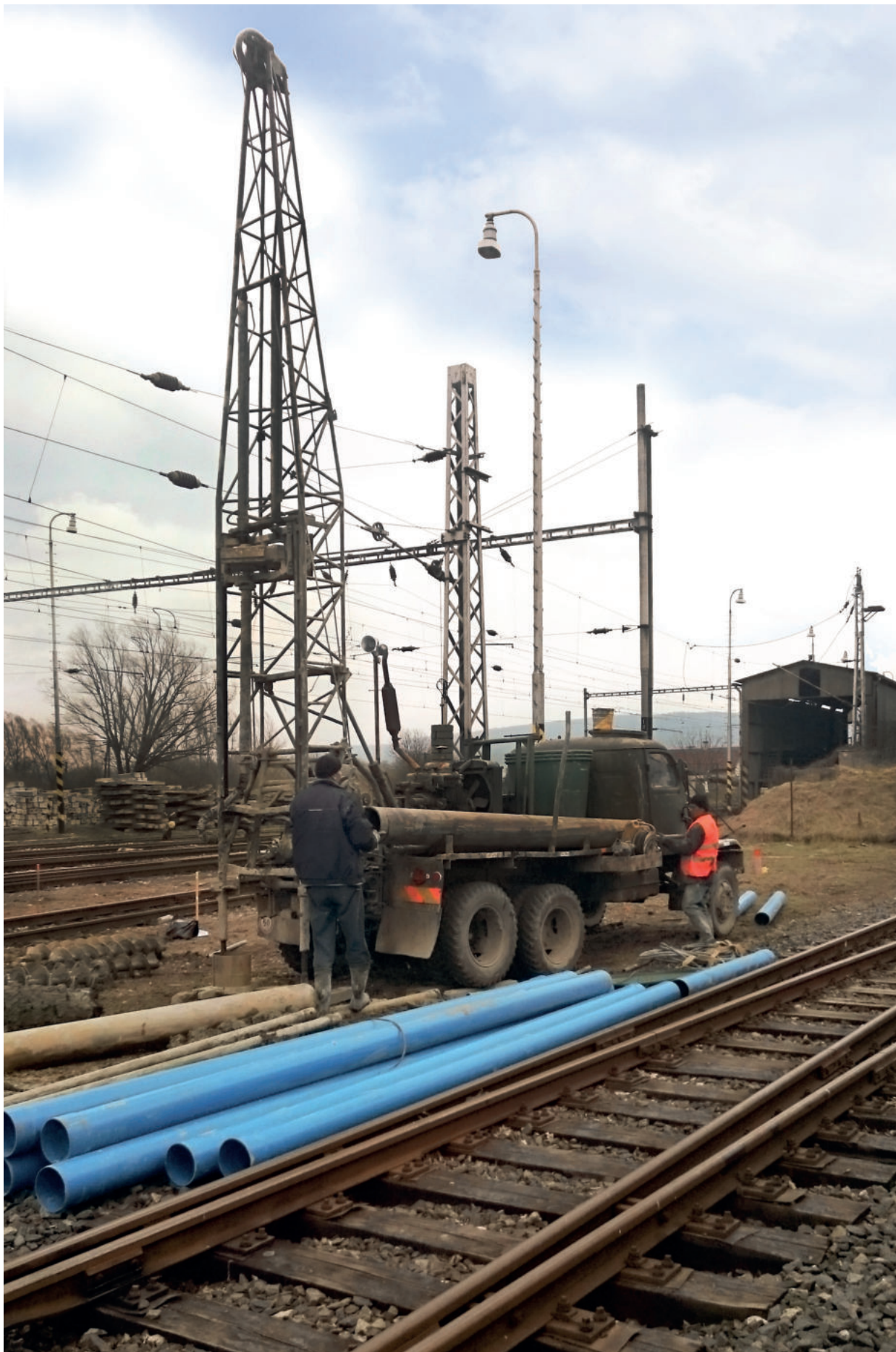
Budovanie sanačných vrtov v priestore koľajiska pred objektom rušňového depa v Jablonici
