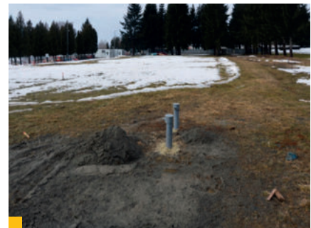
22 Z priebehu sanačných prác v lokalite Garážové dvory [14]
