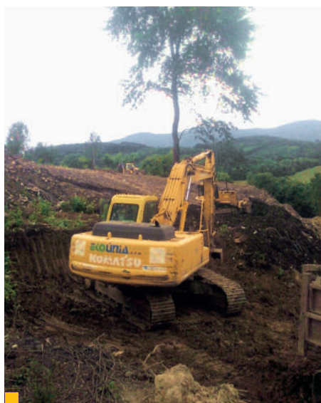
5 Odťažba kontaminovaných zemín
