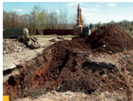
26 Výkop na mieste umývacieho mostíka. Znečistené polohy zeminy ropnými látkami majú tmavšie sfarbenie [15]
