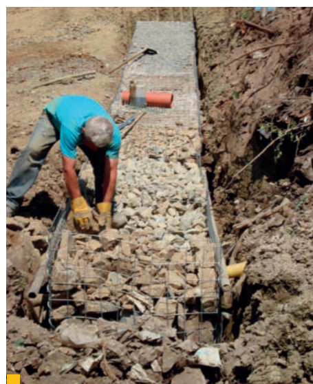
9 Stabilizácia svahu gabiónovým múrom
