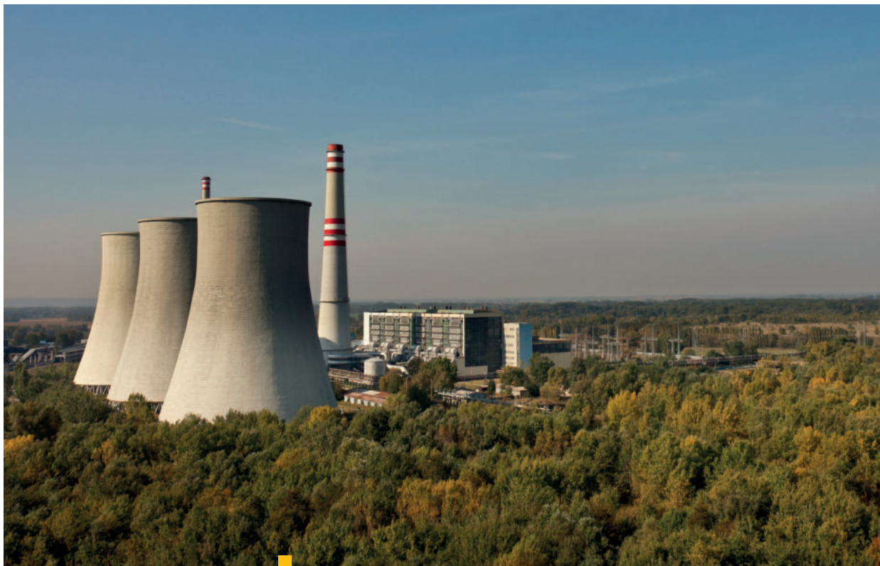
1 Pohľad na areál Elektrárne Vojany
