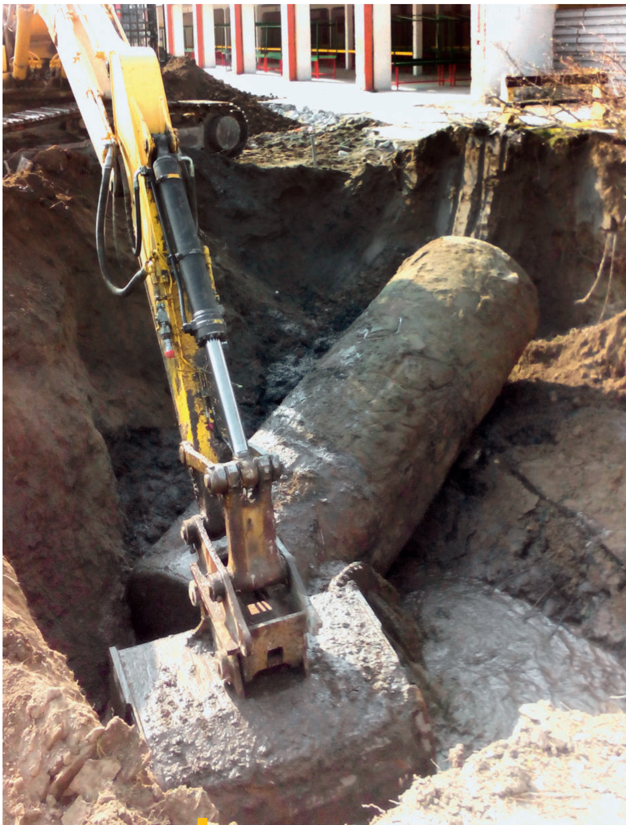
11 Odstránenie dvoch kovových nádrží počas vykopových prác v blízkosti budovy Mestskej polície
