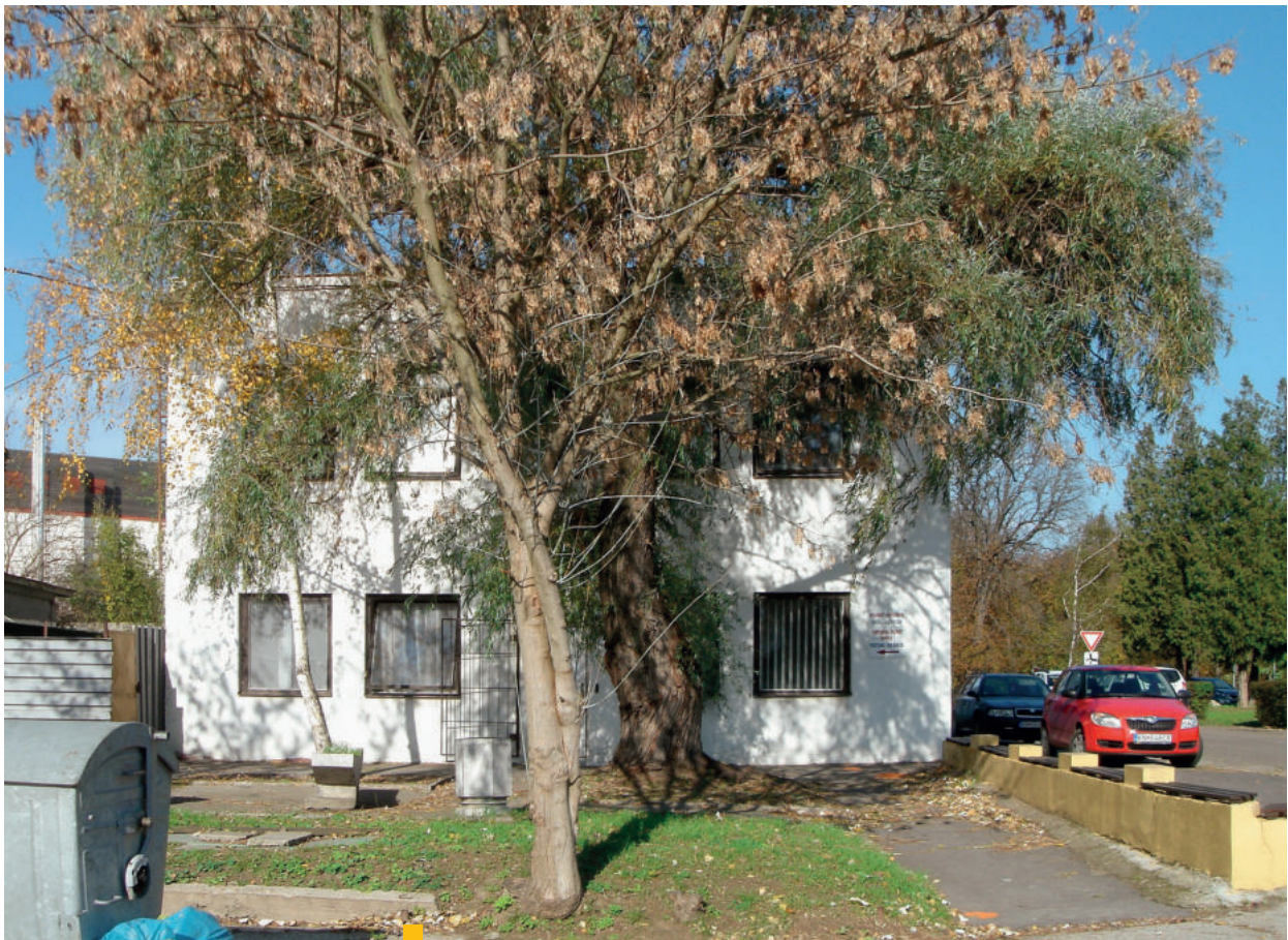
3 Oblasť Autopark I – budova Mestskej polície
