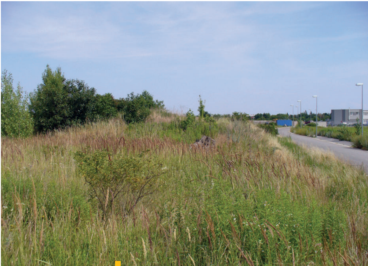
1 b Skládka je situovaná vľavo od cesty
