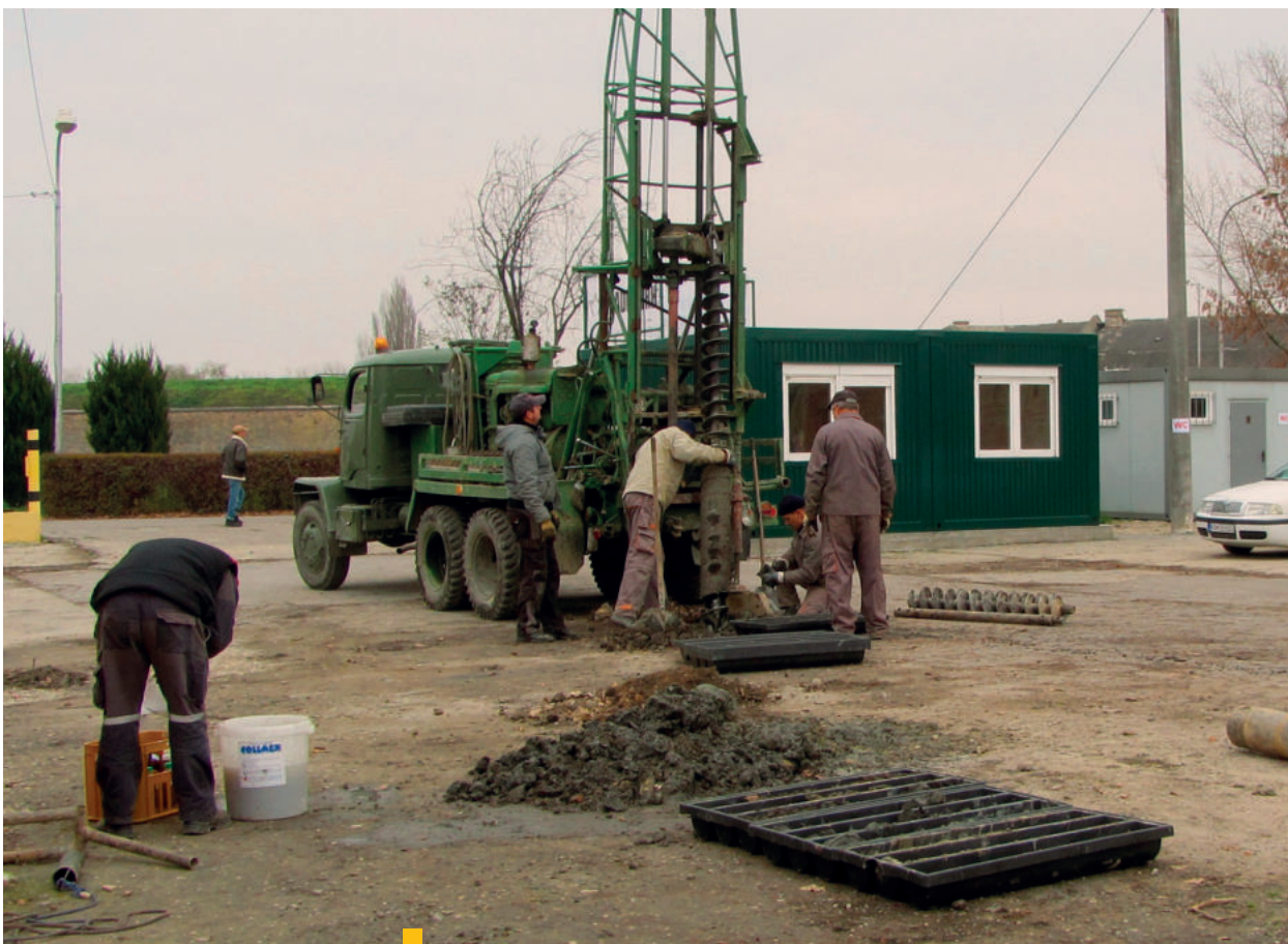
9 Oblasť Autopark I – vrtné práce
