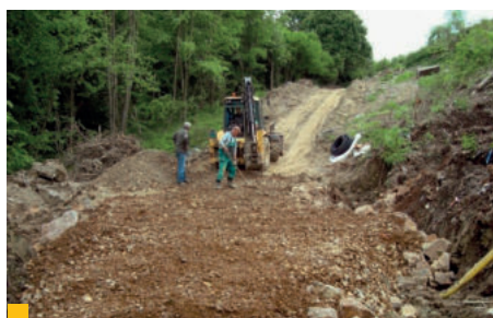
4 Budovanie účelovej cesty
