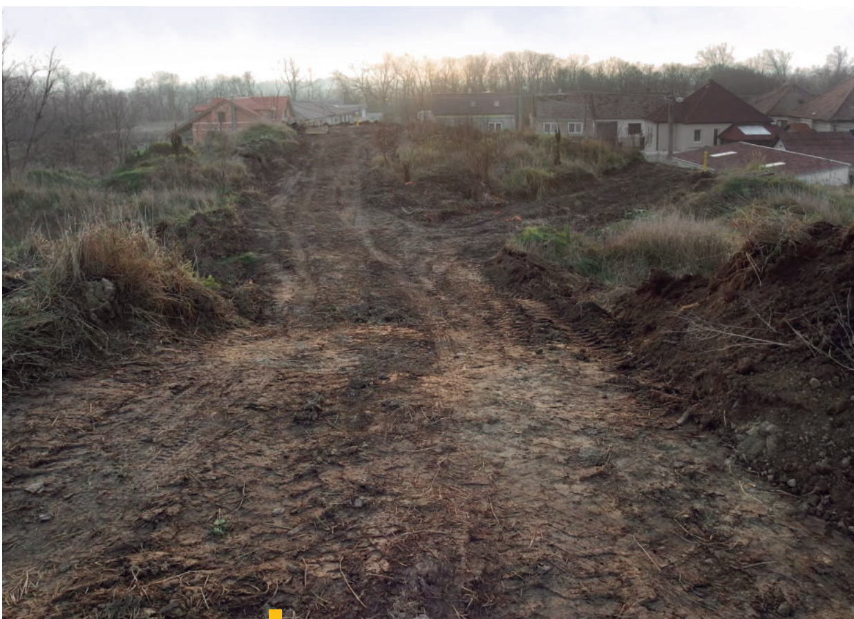
6 Obr. č. 4 a 5 – územie skládky pred začatím sanačných prác (2014) zdroj: MŽP SR
