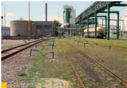
8 Infiltračné drény počas prvej etapy v okolí nádrží
