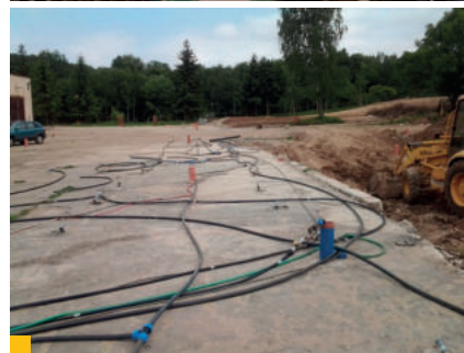
8 | 9 Príprava NPAL v sanačnej technológii a rozvody do aplikačných vrtov
