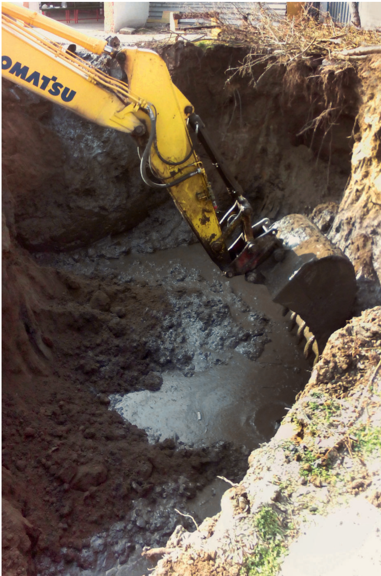
Odťažba znečistených zemin počas sanácie zemin ex situ v lokalite Komárno – areál po Sovietskej armáde, oblasť Autopark I
