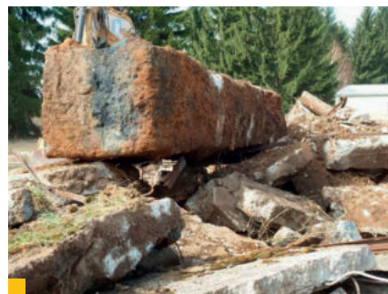
27 Znečistený betónový blok pred rozbitím. [15]
