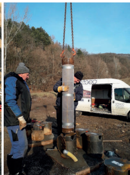
31 | 32 Zabudované reakčné brány a osádzanie reakčných košov
