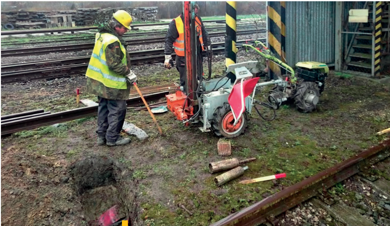
6 Hĺbenie ventingových vrtov pomocou miniatúrnej vrtnej súpravy, aby sa zamedzilo kolízii s nebezpečným trakčným vedením | zdroj: MŽP SR
