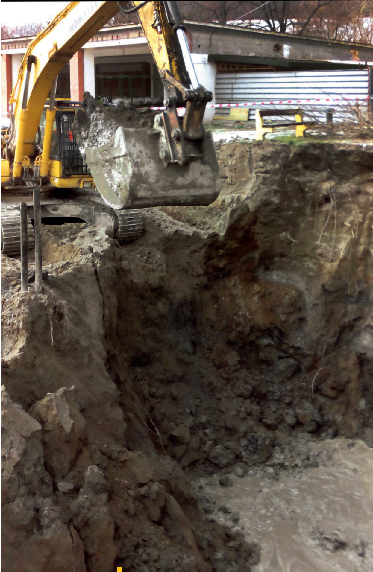
14 Obr. 13 a 14 – sanácia zemin ex situ v oblasti Autopark I
