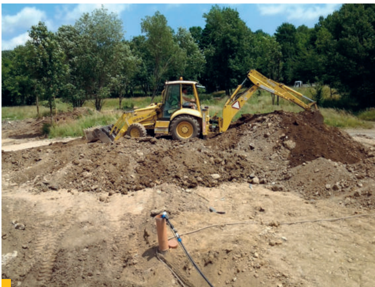
7 Prekopávanie a prevzdušňovanie kontaminovanej zeminy – príprava na biodegradáciu
