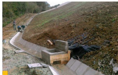
7 Kontrolná šachta 2 – dolný rigol
