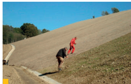
6 Ukladanie biodegradovateľnej rohože
