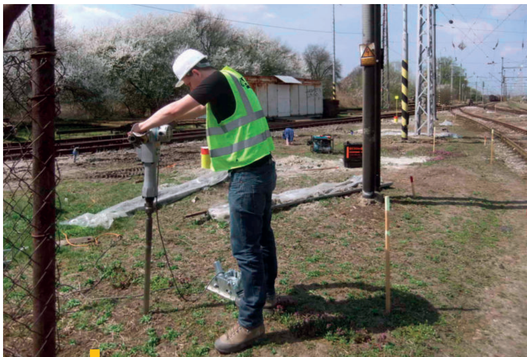
7 Opatrné hĺbenie ventingových vrtov | zdroj: MŽP SR
