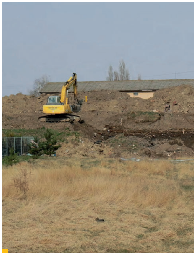
7 Začiatok sanačných prác | zdroj: MŽP SR
