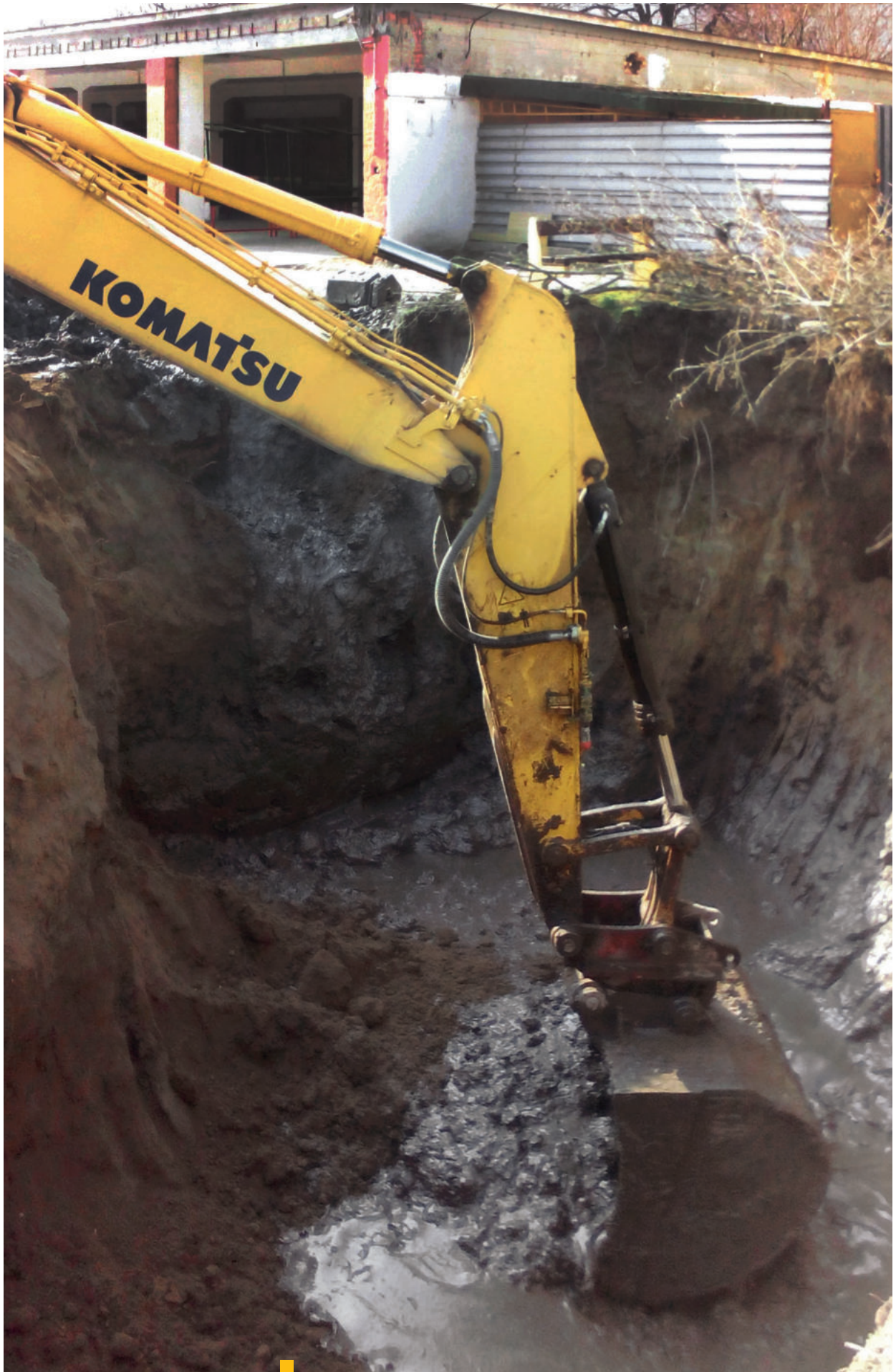
12 Odťahovanie znečistených zemin v oblasti Autopark I
