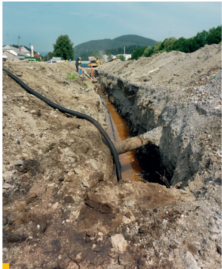
10 Sanácia znečistených zemin in situ | zdroj: MŽP SR
