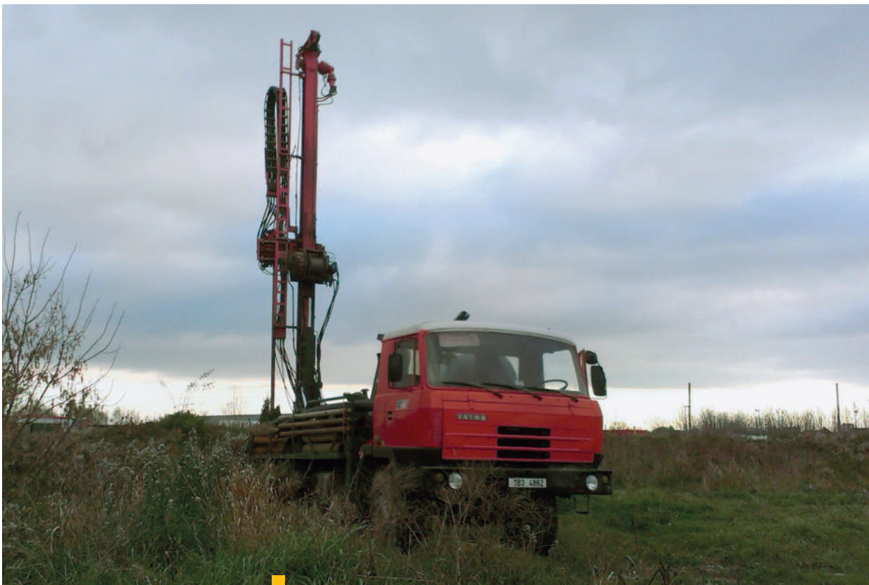
3b Obr. 3a a 3b – vrtné práce – hydrogeologické monitorovacie vrty a prieskumné vrty
