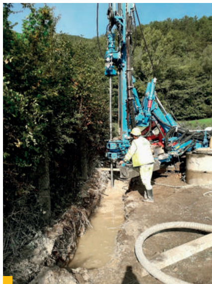
27 | 28 Tryskanie podzemnej tesniacej steny
