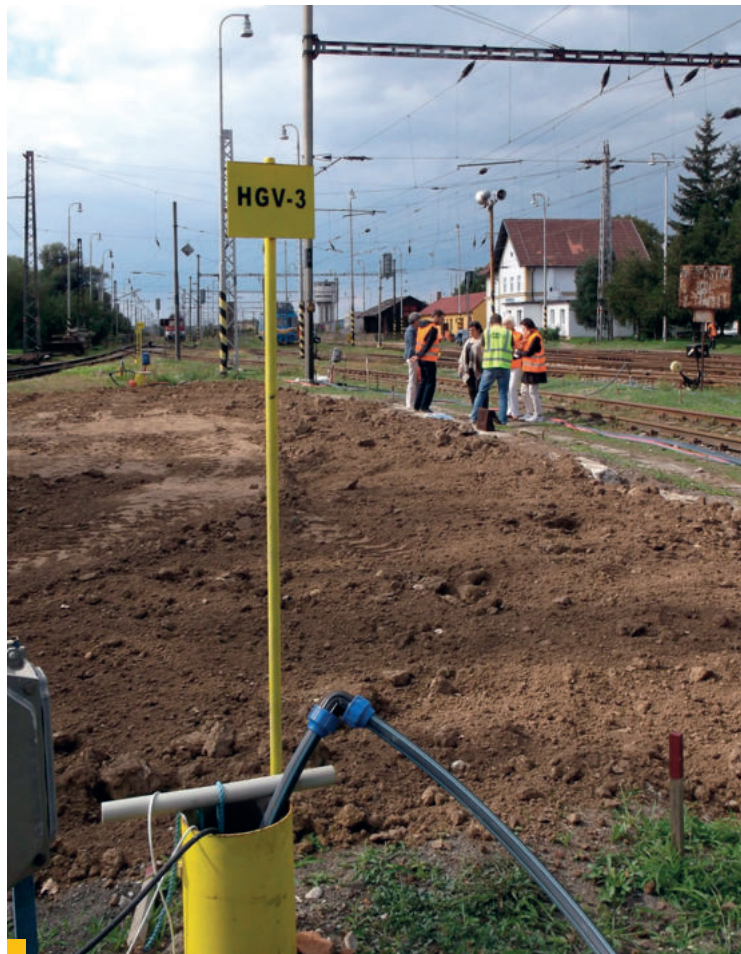
17 Záber z kontrolného dňa počas sanácie
