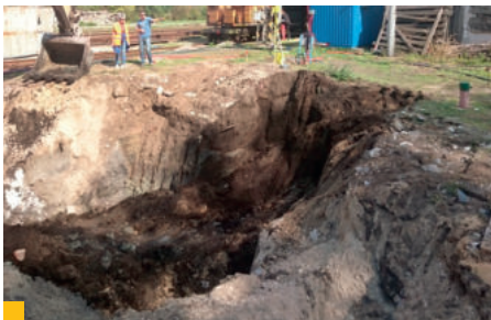
16 Odťahba kontaminovaných zemin. Na zábere sú viditeľné tmavo sfarbené kontaminované zeminu priamo spod zdroja znečistenia lokality – dvoch podzemných nádrží.
