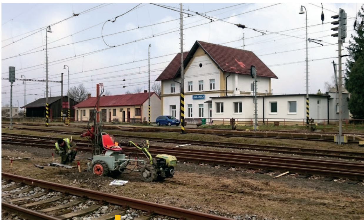
3 Na hĺbenie ventingových vrtov v priestore koľajiska sa využívala miniatúrna vrtná súprava, aby sa zamedzilo kolízii s nebezpečným trakčným vedením.
