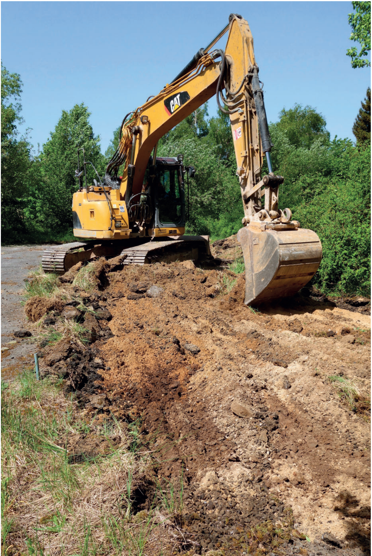
Odstraňovanie znečistenej zeminu počas sanačných prác v lokalite Lešť (vojenský obvod) – Garážové dvory
