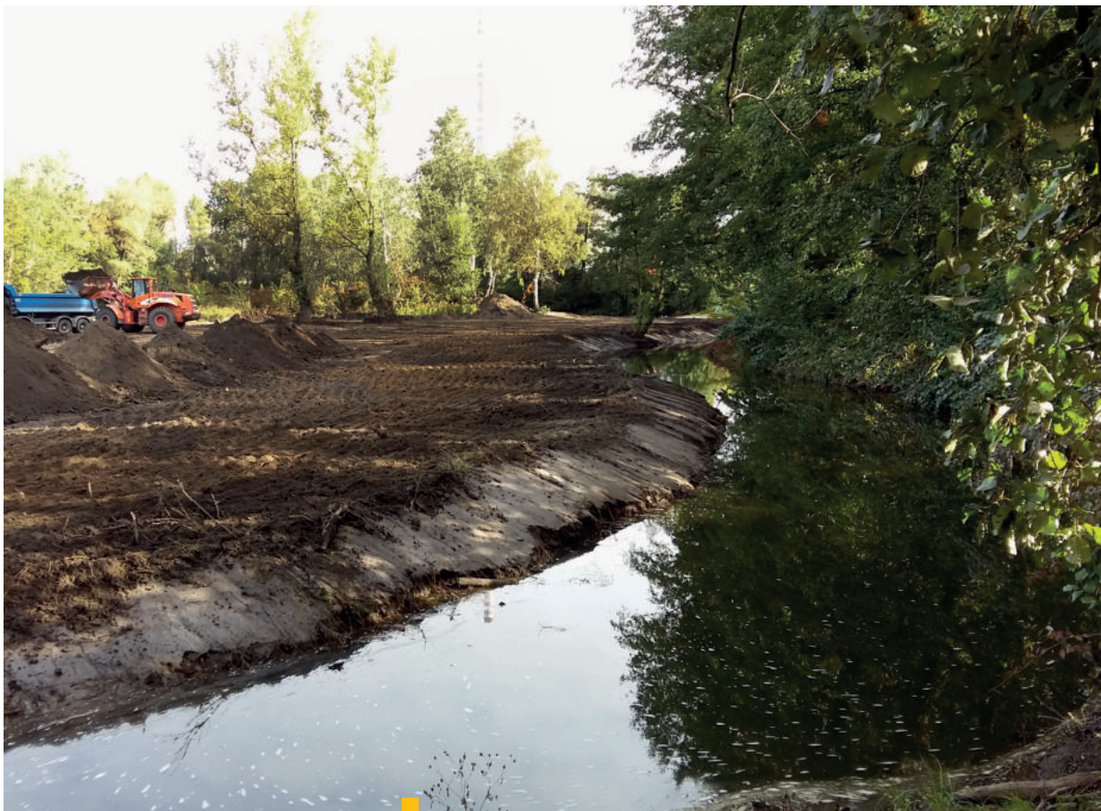
20 Pohľad na lokalitu Zemiarsky potok počas sanácie
