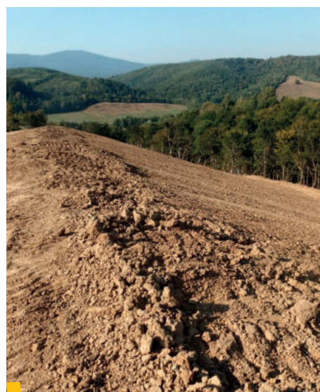
8 Úprava tvaru skládky | zdroj: MŽP SR
