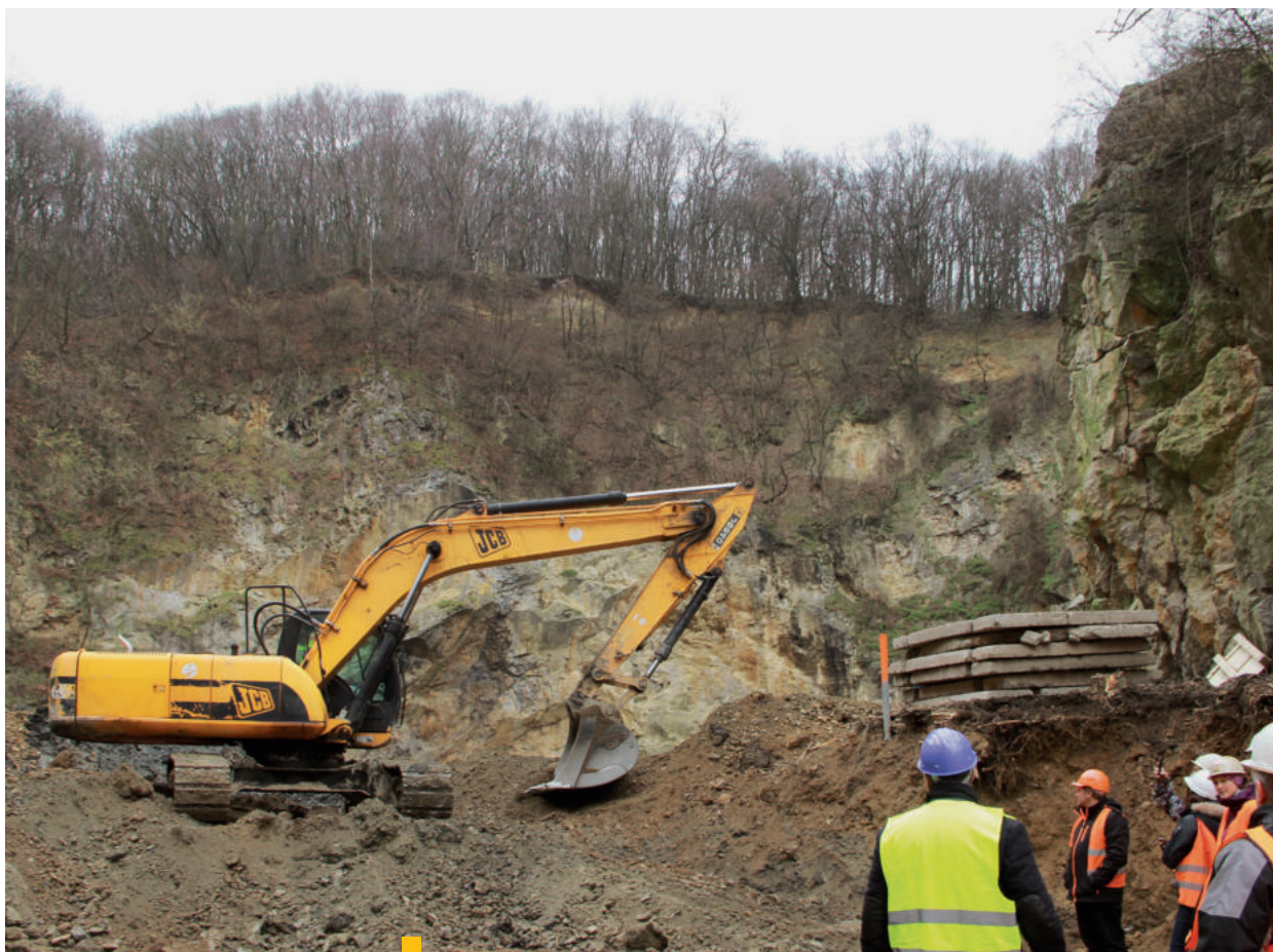
13 Obr. č. 11, 12 a 13 – priebeh sanácie EZ v kameňolome Srdce sledovali počas exkurzie aj účastníci tréningového kurzu vysokoškolských pedagógov a doktorandov (Modra, 21. – 23. január 2015) financovaného zo zdrojov OP ŽP v rámci osvetového projektu INTEGRÁCIA, ITMS kód projektu: 24140110300, prijímateľ NFP: SAŽP, termín realizácie: 9/2014 – 8/2015 | zdroj: archív SAŽP
