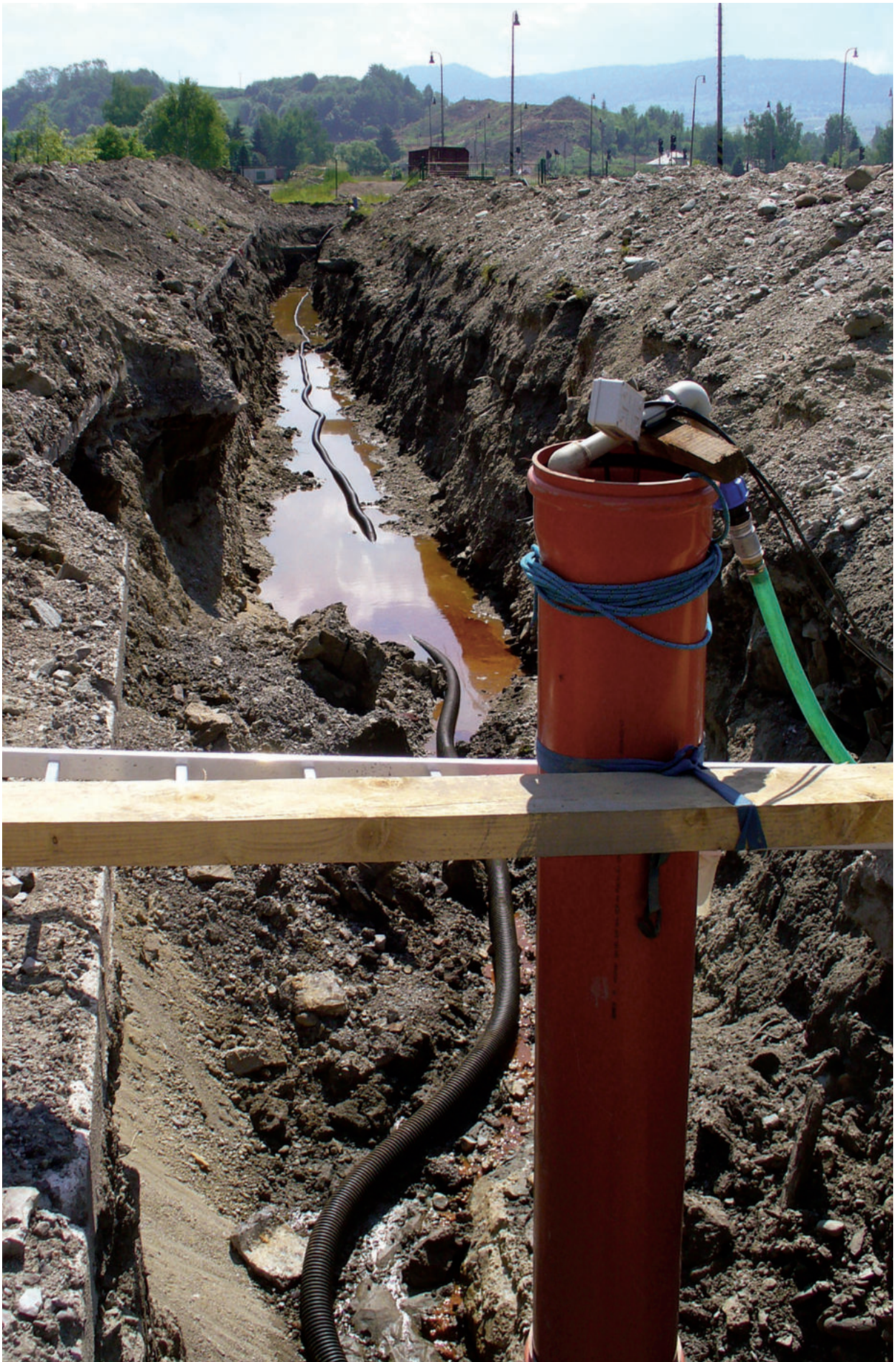
Brezno – železničná stanica – sanácia znečistených zemín in situ
