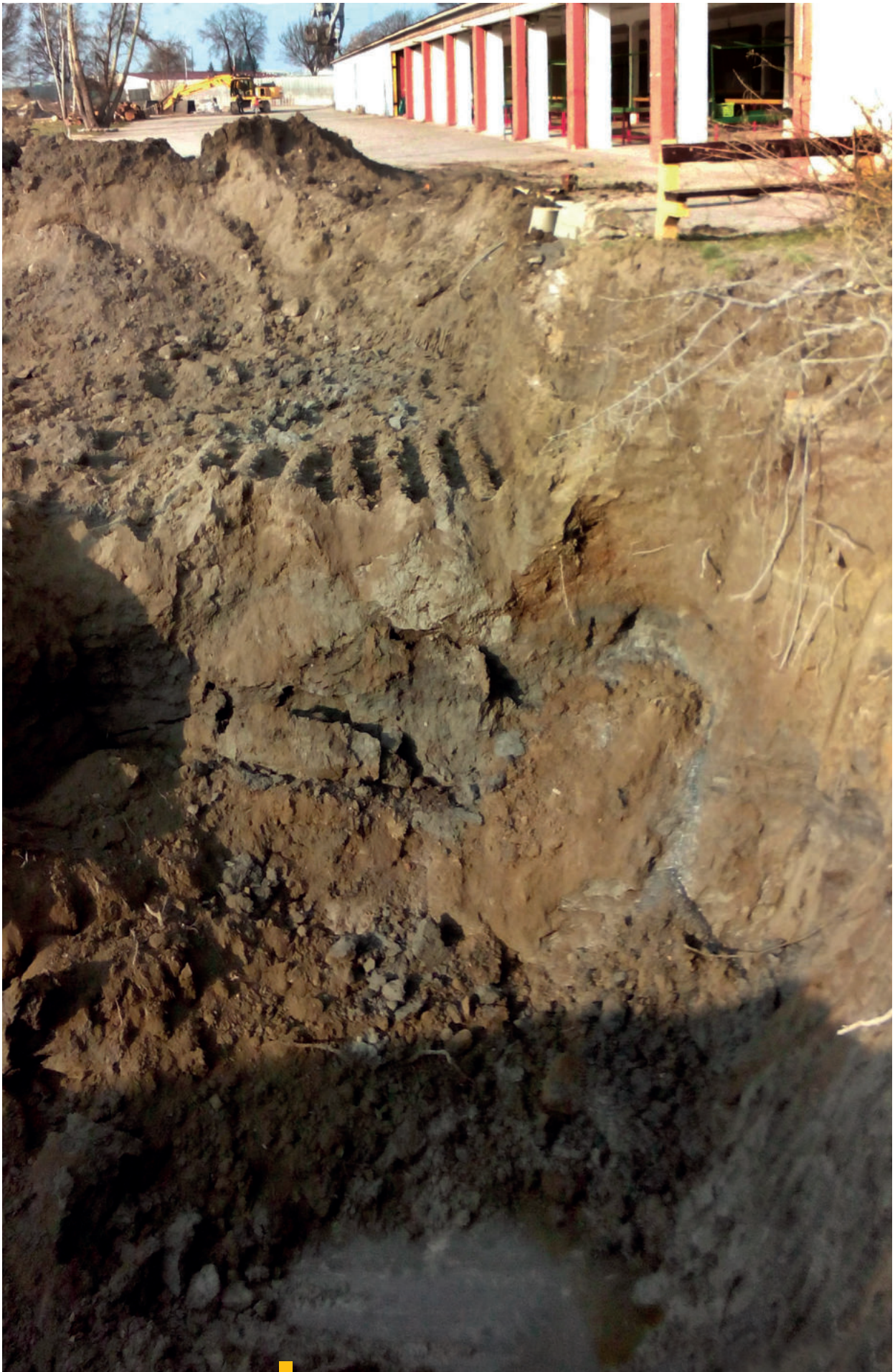
15 Sanácia zemin ex situ v oblasti Autopark I – zavezenie výkopovej jamy
