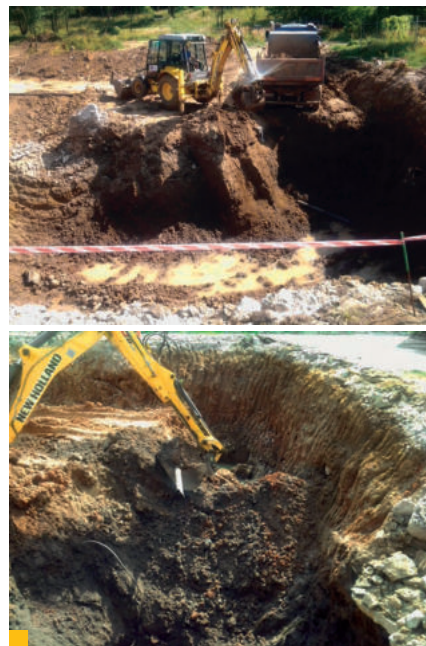
3 | 4 Sanácia zemín ex situ – výkopové práce v čiastkovej lokalite Pekáreň
