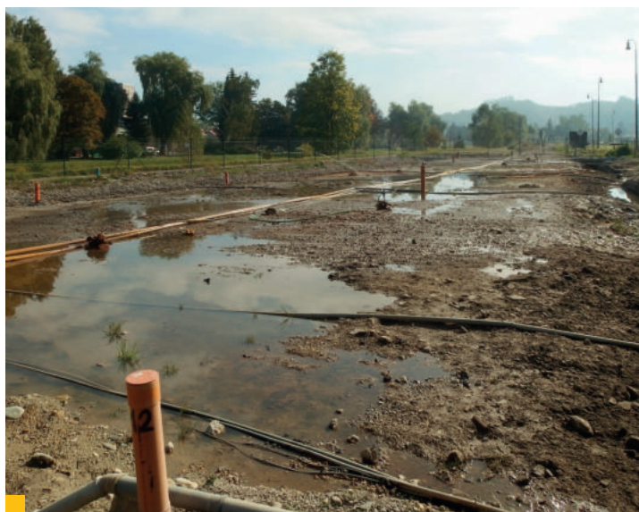
6 Sanácia znečistených zemín in situ | zdroj: MŽP SR
