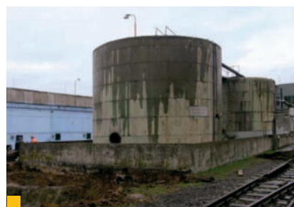
4 Mazutové nádrže počas prvej etapy sanácie
