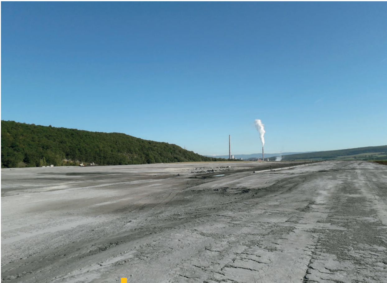
25 Pohľad na dočasné odkalisko Elektrárne Nováky (ENO)
