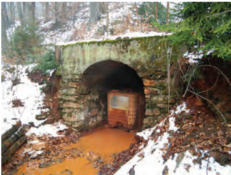
Obr. 4 Štôľňa Agnes s experimentálnymi kontajnermi na pasívne čistenie vôd
