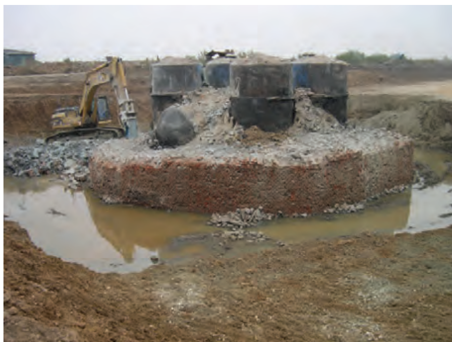
Obr. 2 Likvidácia neznámych látok vnútri podzemných bunkrov, vpravo odkopanie a demolácia podzemných bunkrov s nádržami PHM (5 x 20 m 3 )
