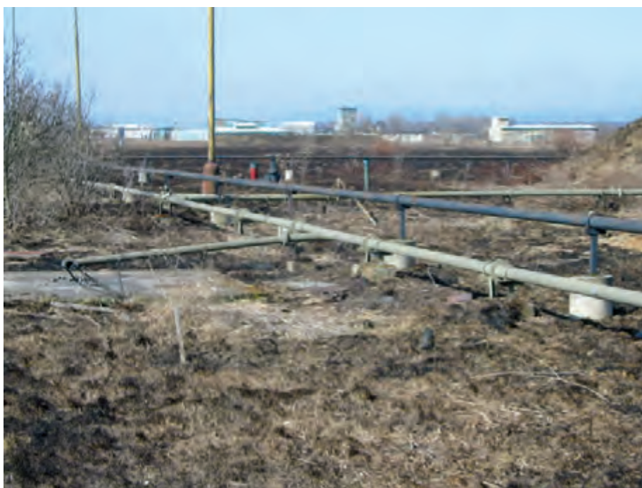
Obr. 1 Takto vyzeral areál vojenského letiska pred začiatkom sanácie. Vľavo podzemné bunkre s nádržami PHM, vpravo potrubné rozvody palív k stojiskám lietadiel
