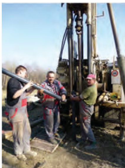
Z realizácie monitorovacích vrtov v teréne.
