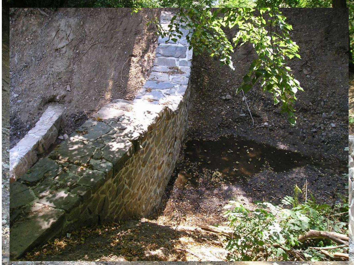
Zastavení chodu štěrků – Vznik hladové vody
